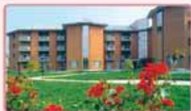
Residenza Villa Antea VIGEVANO (PV)
